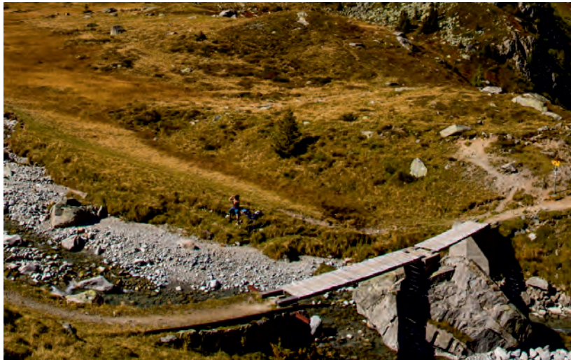
Die alte Brücke früher...
